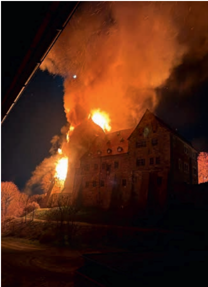
Vor den aus dem Marstall schlagenden Flammen ist der Palasturm zu erkennen, der glücklicherweise vom Feuer verschont geblieben ist. Foto: Privat
